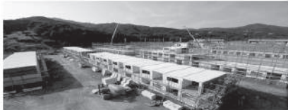
女川町・コンテナハウス
